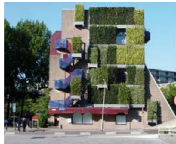
Green facades at Sint Jacobsplaats
